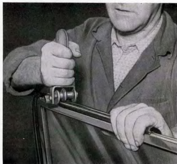
Kuva K 18. Tiivistyskumin asentaminen kehykseen kiinnityslaitteella
