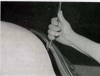
Kuva K 22. Tuulilasia paikalleen asennettaessa on tiivistyskumi saatettava oikeaan asentoon ylhäältä
