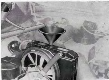
Kuva M 79. Jäähdytysnesteen täyttö
